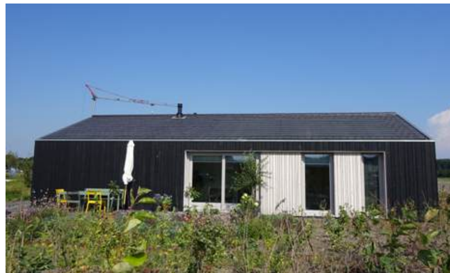
PV-panelen zijn in het dakvlak geïntegreerd door toepassing van zonnedakpannen.
