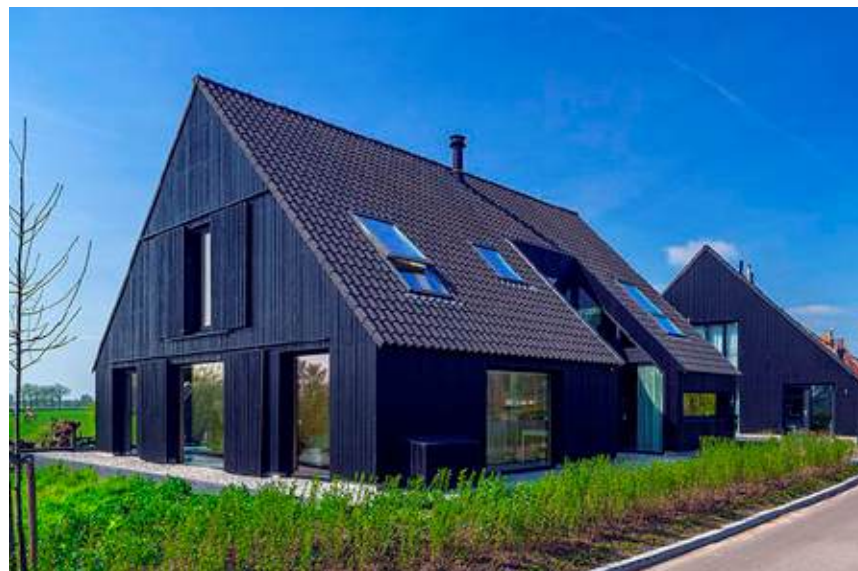
Hout en pannen, grote gevelopeningen, insnijding in volume met opgetrokken daklijn.
