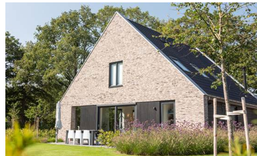
Extra brede gevelopeningen gecombineerd met houten gevelpanelen.
